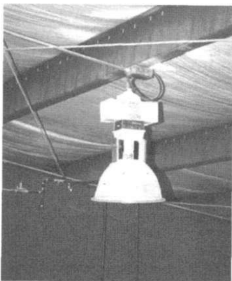
8.12. Установка стального каркаса в больших зданиях требует специального оборудования и обученных исполнителей. Обратите внимание на использование стекловолокна для теплоизоляции, обеспечивающей удаление водяного пара
