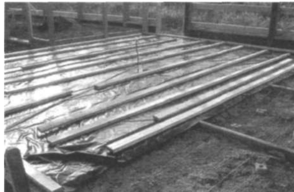
10.19. Плита застывающего бетона накрывается пленкой, чтобы она не растрескалась при высыхании
