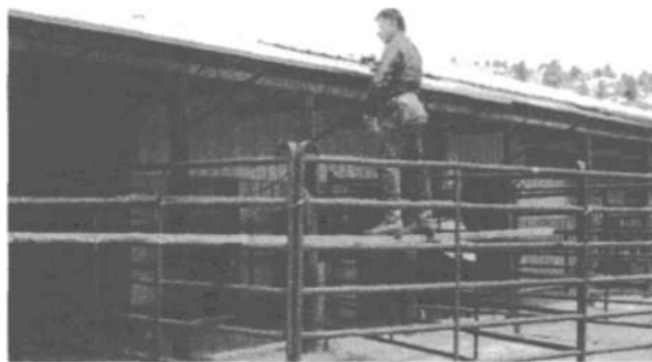
10.22. Металлические конструкции и панели, используемые для подмостей
