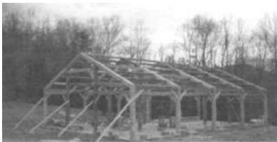
4.11. Каркас конюшни из бруса в процессе строительства.
