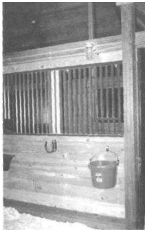
2.4. Хорошая постройка включает в себя выструганные деревянные выступы, защищенные светильники и правильно установленные разделительные решетки
