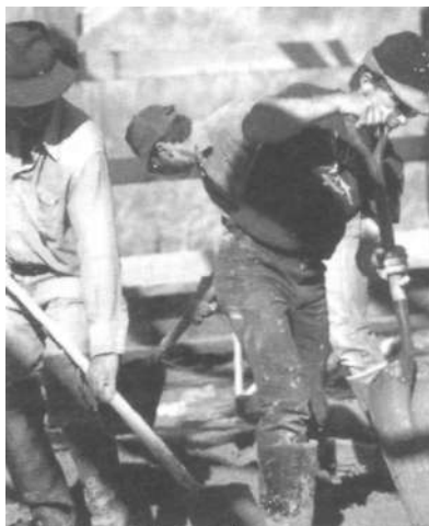
2.12. Вы должны быть готовы попросить помощи на отдельных стадиях строительства, типа бетонирования фундаментов или других работ, которые вам не под силу
