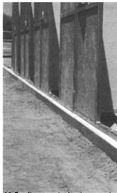
10.7. Бетонный фундамент для модульной конюшни
