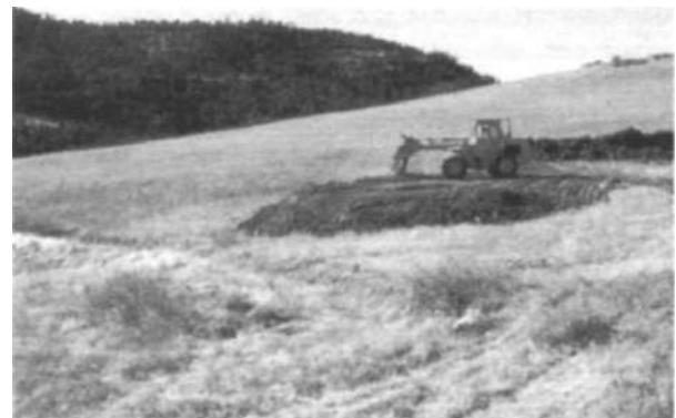
10.4. Строительный участок будет подготовлен на склоне холма
