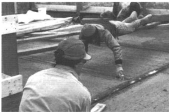
10.18. Затирку и выравнивание углов делают после выравнивания бетона. Обратите внимание на уложенные в бетон бруски размером 50 x 100 мм, которые образуют стыки укладываемого бетона
